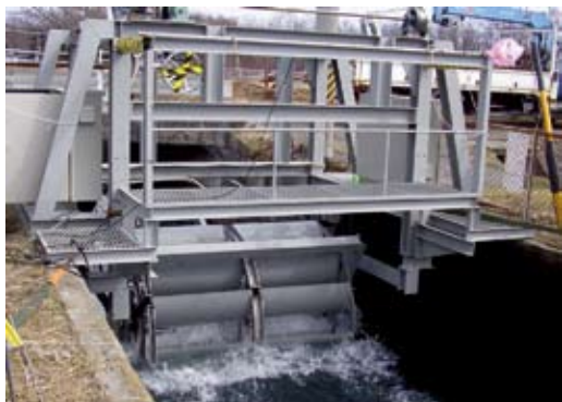
写真 4. 発電効率向上に向けた二連水車化
