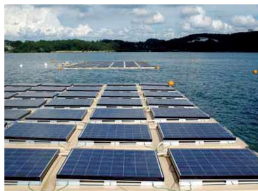
写真1 ため池を利用した太陽光発電（水資源機構 東郷調整池）
