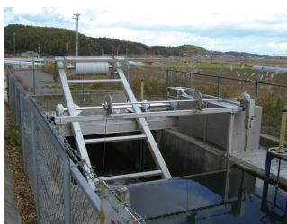
①チェックゲートの設置 （宮川用水地区）
