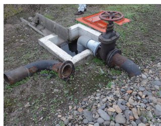
③末端施設のパイプライン化 （妹背牛地区）
