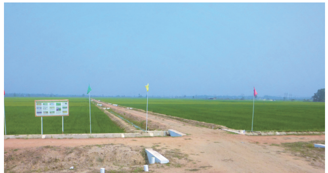
モデルほ場工事完成後 (ミャンマー・オクトウィン郡)
