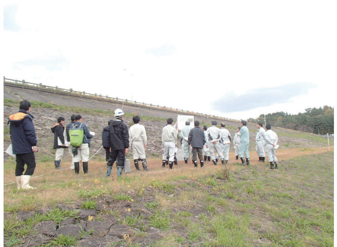
農業用ダム安全性評価委員会における検討状況 (新小戸六ダム、アースフィルダム)
