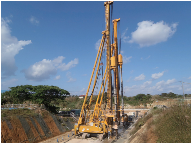
地下ダム止水壁の施工状況 (沖永良部地下ダム)
