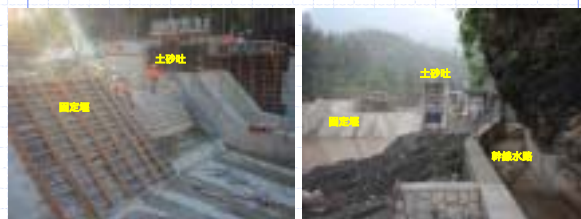
既設の堰を70cm嵩上げる工事 2008/11/06
