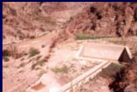
プロジェクトによって建設された溜池
