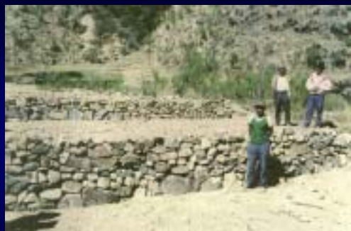
コンクール手法により農民自らが自発的に ベンチテラスを構築
