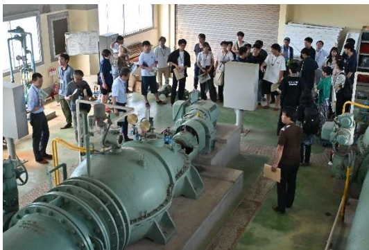
車場揚水機場
