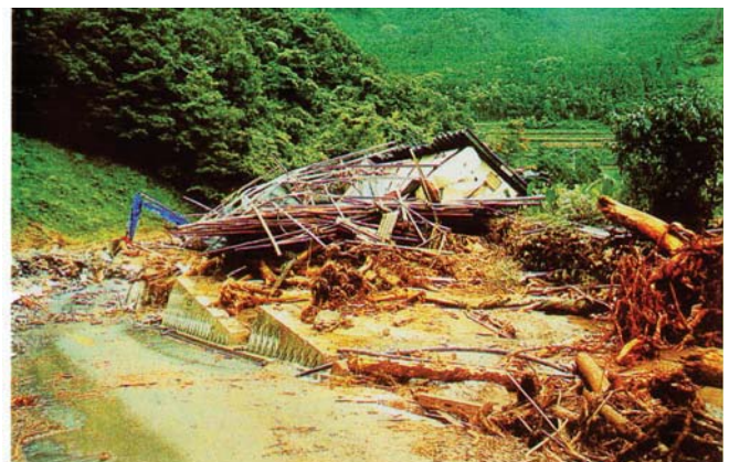
・平成11年9月15日 台風16号による豪雨で惣田谷で発生した土石流により倉庫が全壊したほか 流域各所で被害が発生した(川内町)
