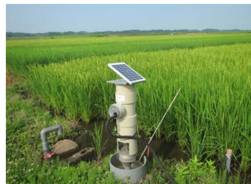
自動給水栓稼動状況
