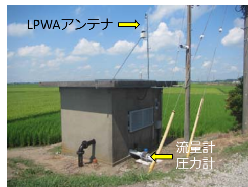
ポンプ場の状況
